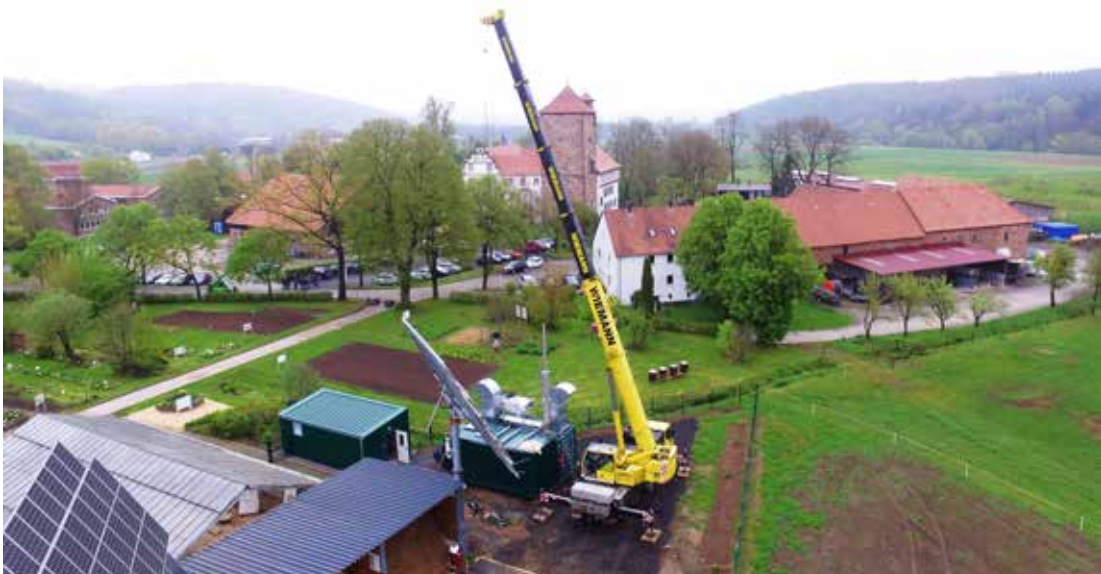
Abb. 2: Aufstellung eines inselnetzfähigen Biogas-BHKW am Hessischen Biogas Forschungszentrum (HBFZ) in Bad Hersfeld (© Fraunhofer IEE)
